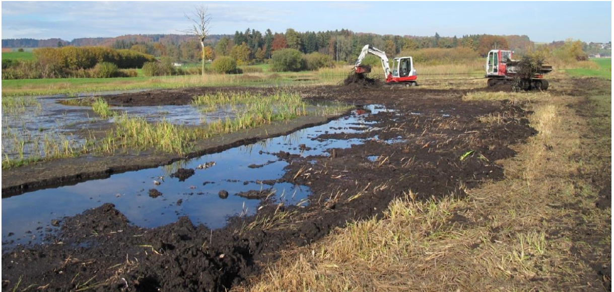
Abb. 8. Baggern für die Natur. Die Ufer des grossen Flachwassers werden abgeschürft (Foto: R. Wüst-Graf).
